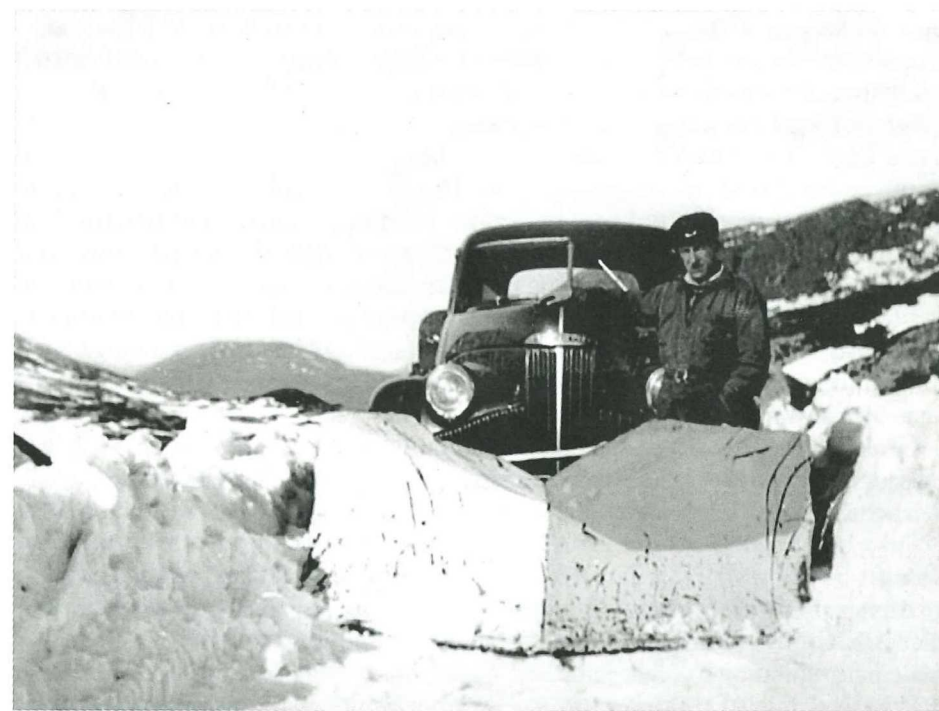
Håkon Ynnesdal i arbeid med lastebil og plog.
